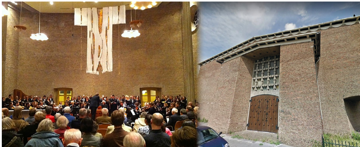
Viering in de oude Thomaskerk (l). Blijft deze voorgevel (r) met kruisvormen en spreuk? Boven de deur staat: 'Laat u ook zelf als levende stenen gebruiken voor de bouw van een geestelijk huis - 1 Ptr 2:5.'
